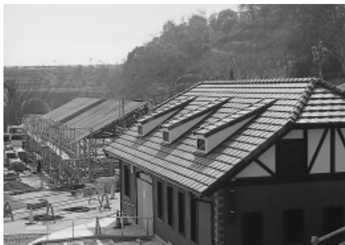
工事中の「道の駅」トイレとサービス棟
